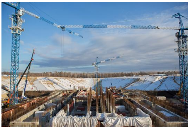
На строительной площадке космодрома «Восточный».
