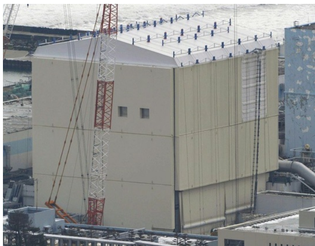
Защитный саркофаг на АЭС "Фукусима-1"
