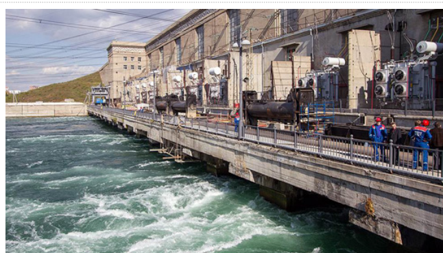
Гидроэнергетика — стержень экономики региона Фото: Коммерсантъ / Евгений Козырев
