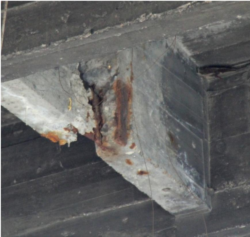
Поперечная балка - несущий элемент моста. Вид снизу. Металл и бетон разрушены.
