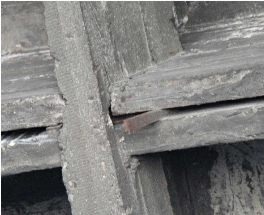
Деформационный шов. Вид снизу. Деревянные колышки забиты для того, чтобы плиты основания не "ходили" друг относительно друга.
