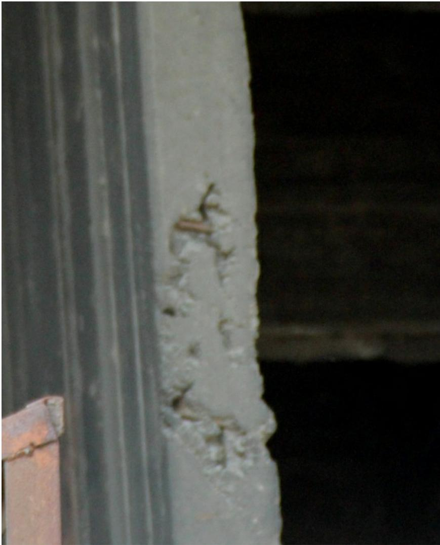
Боковая часть диафрагмы. Хорошо видна степень ее разрушения.
