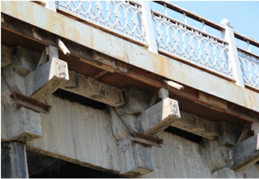
Тротуар, сделанный в 2012 году. Видно, что на старые изношенные консоли вертикально поставили тонкую доску, сверху залили слой бетона толщиной 10 сантиметров, на него водрузили тяжелую ограду и столбы освещения. На чем держится вся конструкция тротуара - непонятно.
