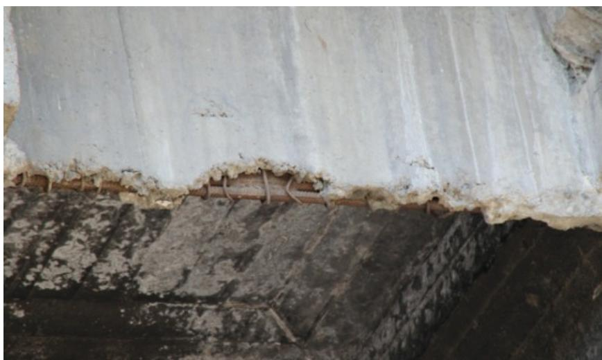
Старая продольная балка, вид снизу. Видно, что бетон разрушился, и арматура подвергается коррозии.
