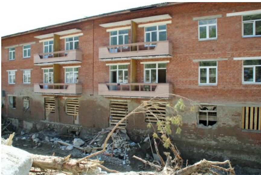
Гостиницу "Саган-Дали" строили хорошо. Стены устояли. Если бы в ста метрах выше гостиницы была построена бетонная стенка - последствий катастрофы можно было бы избежать.
