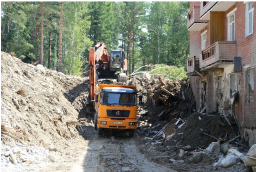
Тяжелая техника работает круглосуточно.
