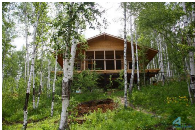
Строительство коттеджей в Ершах.
