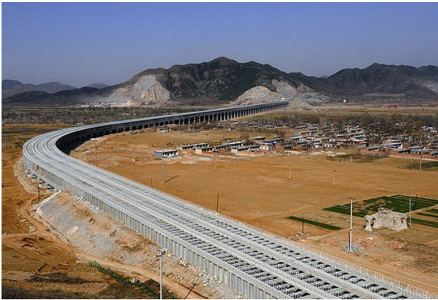
17. Работы над Восточным каналом продолжались 11 лет. В конце прошлого года комплекс был сдан в эксплуатацию. Его общая протяженность составила 1150 километров, на север Китая дополнительно будет перебрасываться до миллиарда кубометров пресной воды в год.
