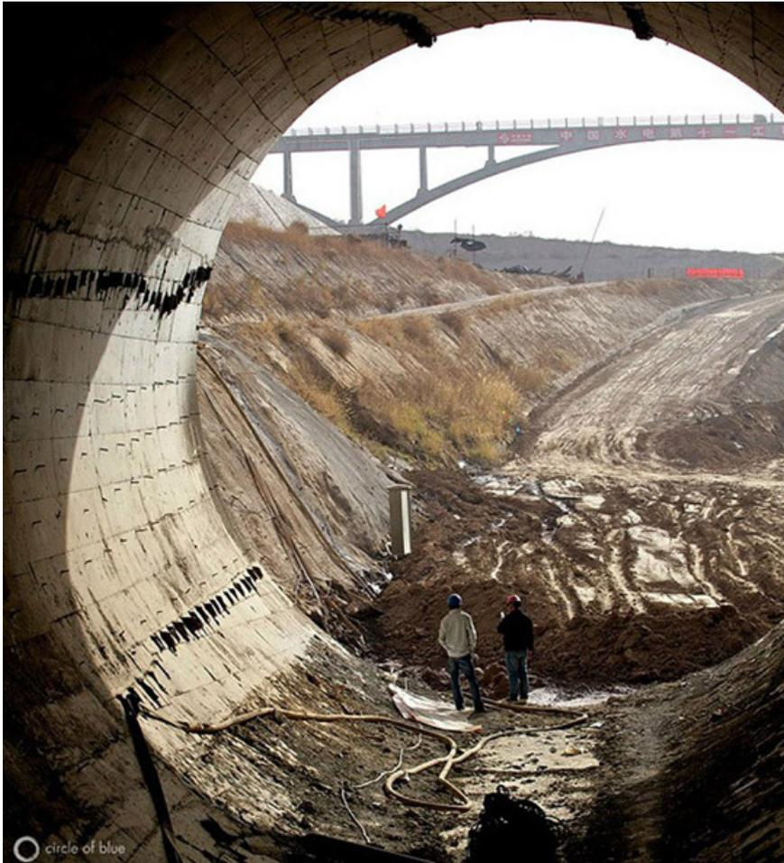
22. Тем не менее, центральный участок «поворота китайских рек» столкнулся с двумя сложными проблемами. Первой из них стала необходимость пересечения Хуанхэ, которую решили ровно так же, как и на востоке, — строительством подземного тоннеля-водовода.
