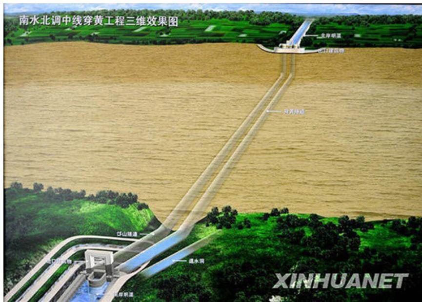
14. Уникальным новым гидротехническим объектом здесь стал подземный комплекс, созданный в месте пересечения Великого канала с Хуанхэ. Воды Янцзы будут форсировать Желтую реку с помощью двух подземных тоннелей-водоводов диаметром 9,3 метра каждый и длиной 585 метров.
