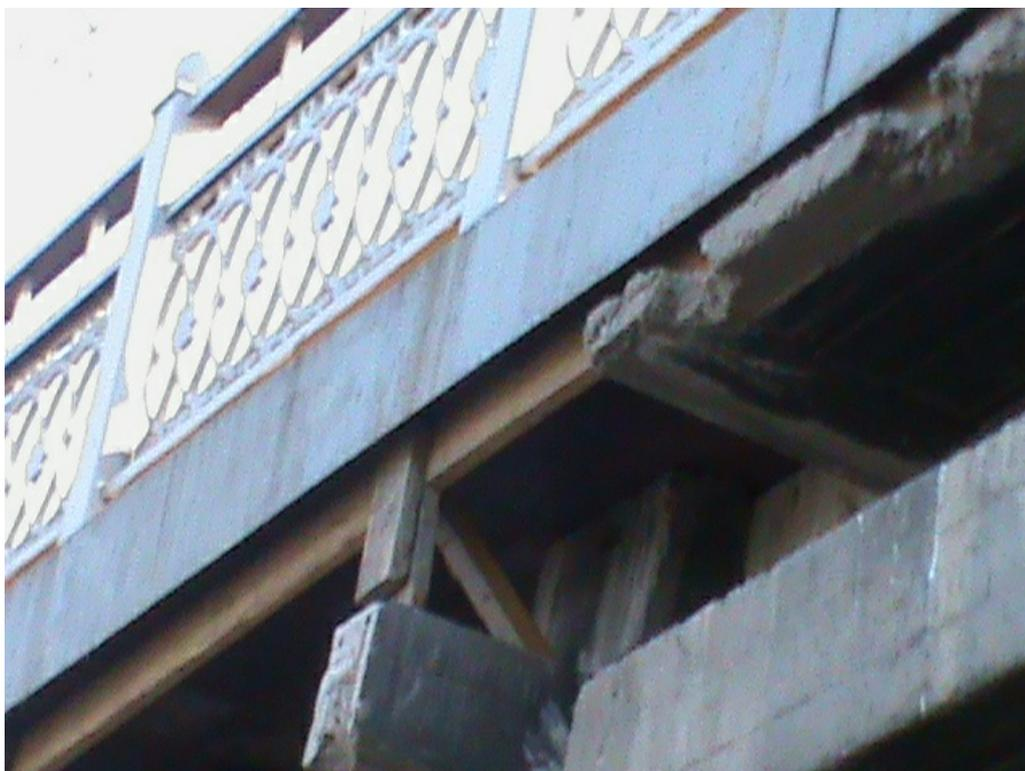
Состояние отремонтированного в 2012 году тротуара. Многотонная конструкция держится на трехсантиметровой доске.
