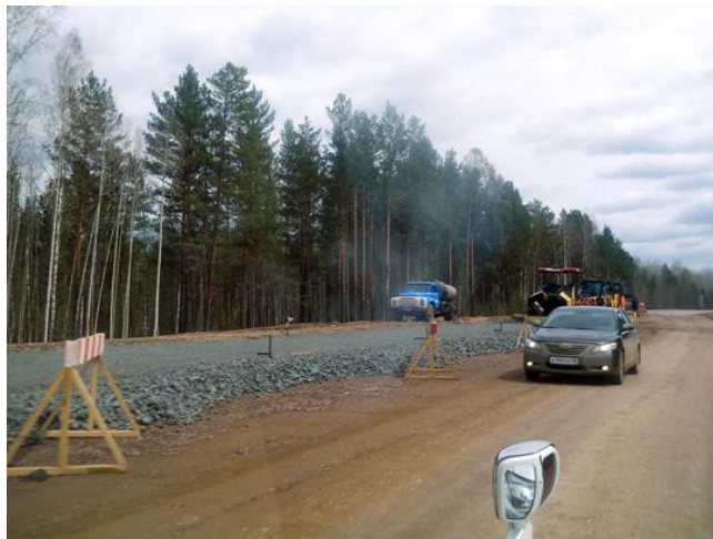
Стройка ЗАО `Труд` на М-53
