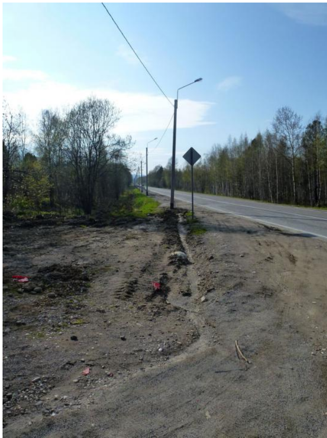
От садоводства `Горный` к садоводству `Бабха`. Видна выемка под бордюры, но тротуар начинается только через 70 метров
