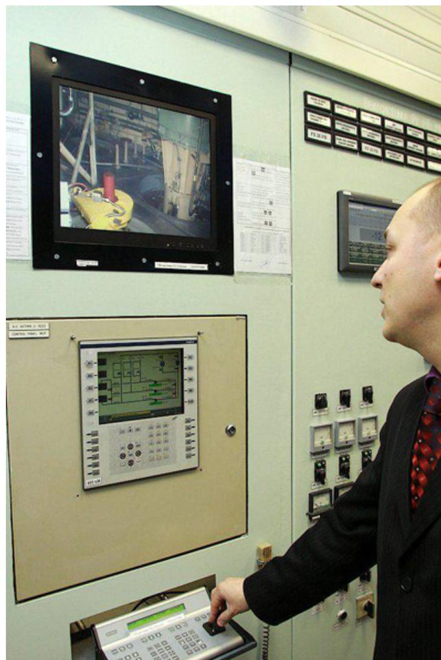
Следующее помещение - блочный щит управления (БЩУ, он же - на заглавном фото), с помощью которого контролируются параметры энергоблока и ведется управление технологическим процессом. Во многих местах станции установлены камеры,
