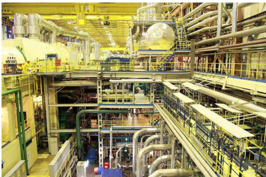
Машинный зал. Здесь установлены турбины (желтое цилиндрическое сооружение слева вверху), на которые поступает нагретый пар. Пар приводит в движение связанный с валом турбины генератор, вырабатывающий электроэнергию. Далее электроэнергия через трансформаторы передается в сеть
