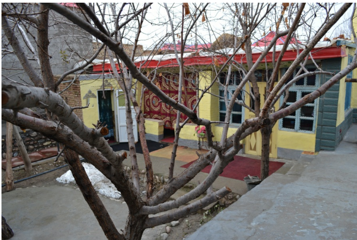
Видно, что всё новое, бетон ещё не просох, одна стена не заштукатурена. Но всё новьё построено на месте старого дома, деревья пожилые уже. Летом под их кронами устраивались и будут устраиваться посиделки с самоваром.
