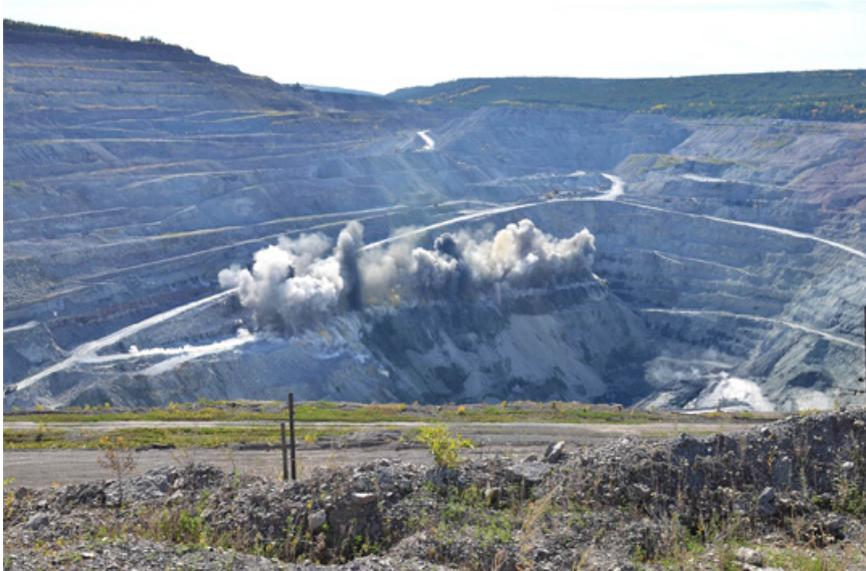
Стандартные взрывы в карьере производятся обычно в объеме не более 200 тысяч кубометров. Но, благодаря участию в подготовке высокопроизводительного экскаватора и слаженной работе трех буровых станков, удалось получить расширенный буровой блок на горизонте 150 метров. Его размеры составили 740 метров в длину и 40 в ширину. Для производства взрыва потребовалось 315 тонн взрывчатых веществ. Объем взорванной горной массы составил 440 тысяч кубометров.
