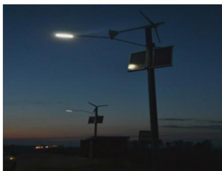
Аккумуляторы заряжаются в светлое время суток от солнца и ветра. Энергии хватает на 10 часов, причем фонари работают даже в пасмурные дни.
