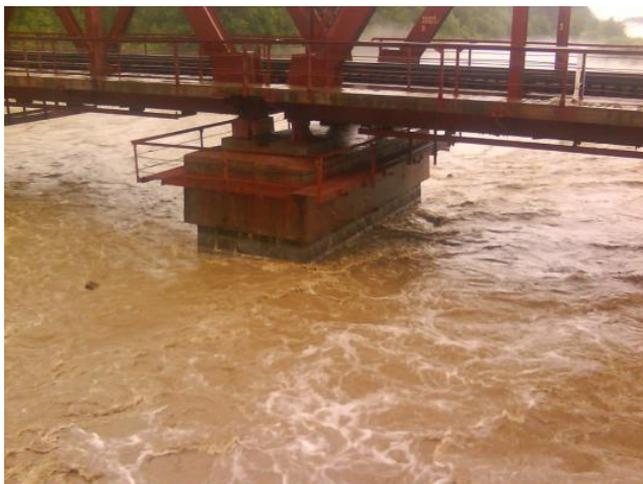
11. На середине моста сильная вибрация от потоков воды и валунов, катящихся по дну и ударяющихся в опору
