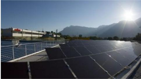
Стены корпуса экоэнергетических инноваций, об окончании строительства которого объявил институт, покрывают 4,5 тысячи панелей солнечных батарей. Они могут вырабатывать 650 кВт электроэнергии, еще 100 кВт обеспечат батареи, установленные на крыше. Это первое в стране здание подобного рода.
