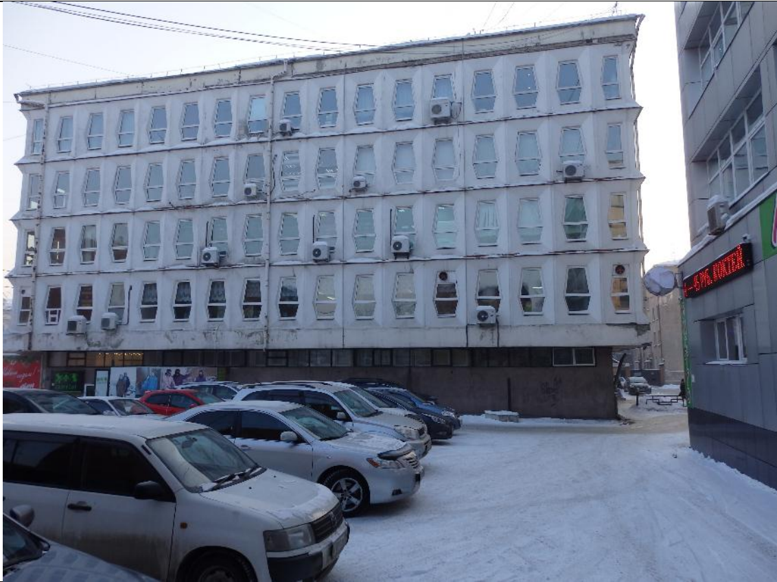
фото 11. Вид фасада здания в осях А-Е/8.
