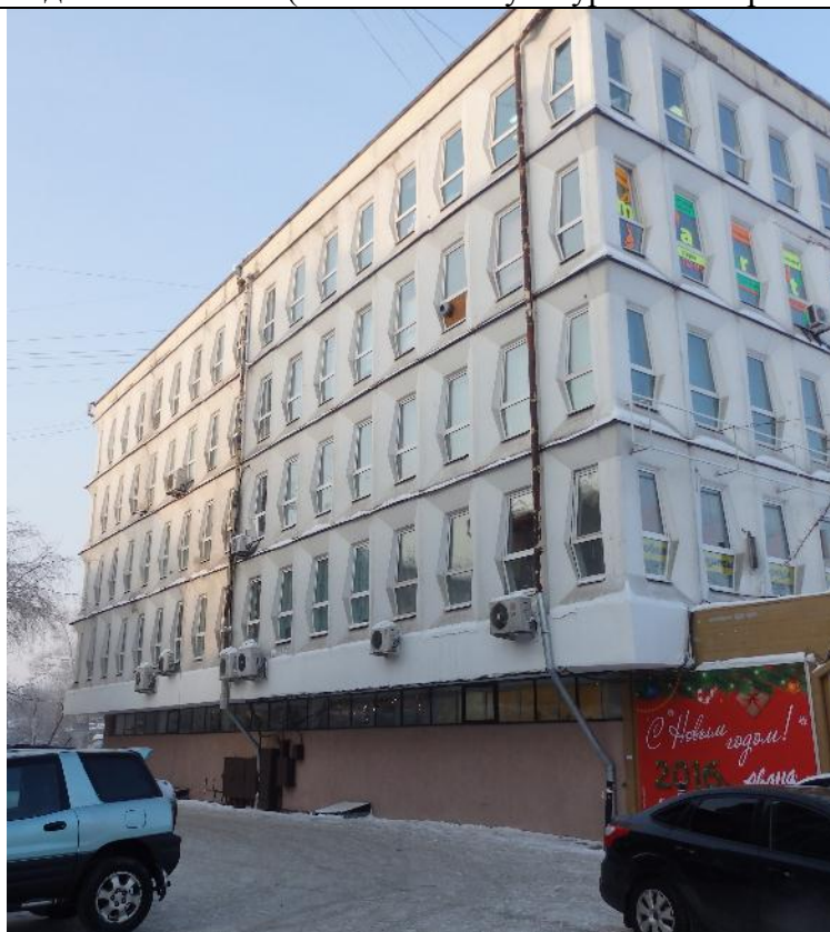
фото 4. Фасад здания в осях Е-А/1.
