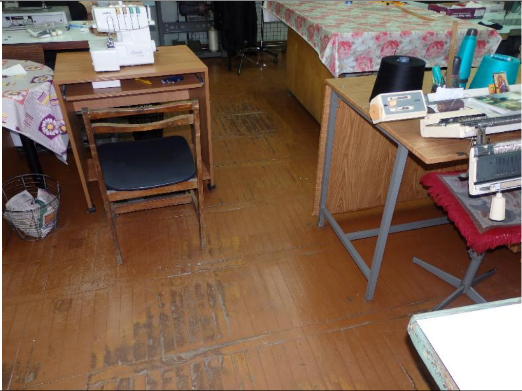
фото 47. В помещениях с паркетными полами зафиксированы стертости поверхности, неровности.
