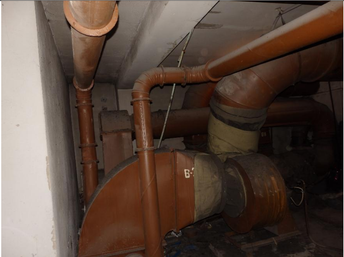
фото 29. Состояние вентиляционного оборудования.
