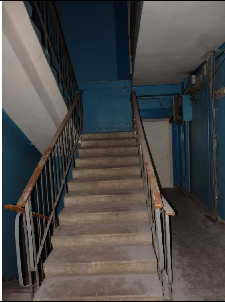
фото 33. Состояние междуэтажной лестничной клетки в осях 3-4/Д-Е.
