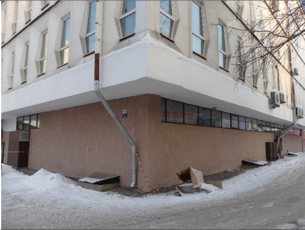
фото 5. Угол здания в осях 8/Е.
