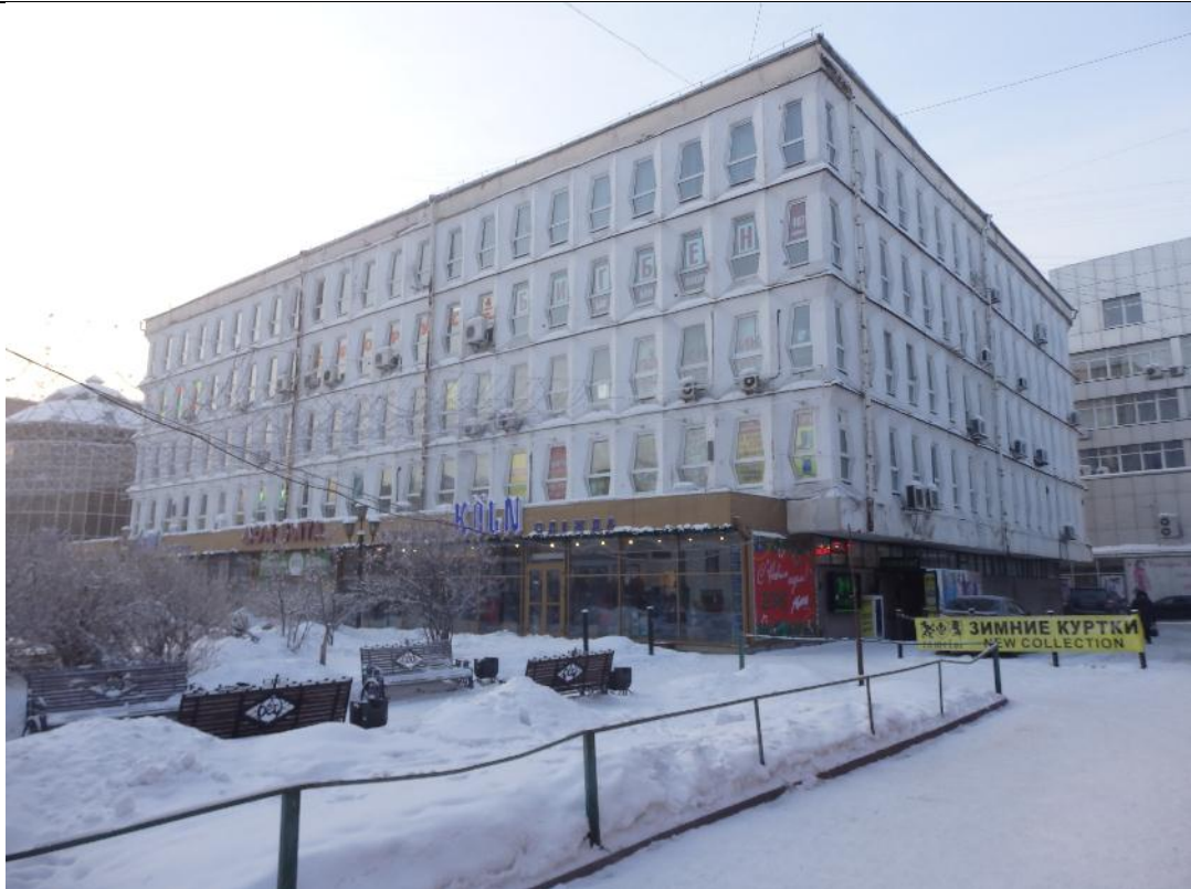
фото 1. Общий вид здания и прилегающей территории.
