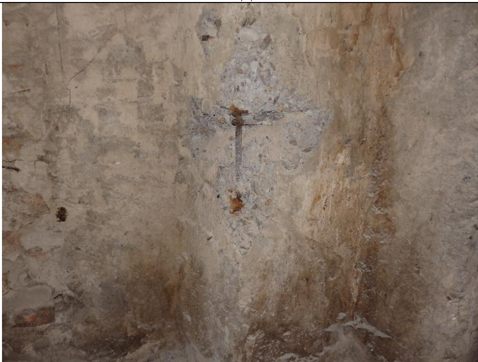
фото 64. Вскрытие №2 произведено на железобетонной внутренней колонне подвала в осях 5/Д.
