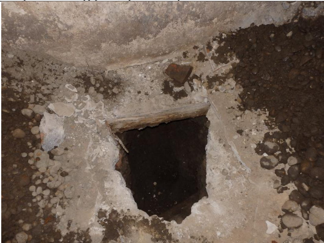
фото 66. Шурф № 2, пройденный у наружной стены подвала в осях 4-5/Е.
