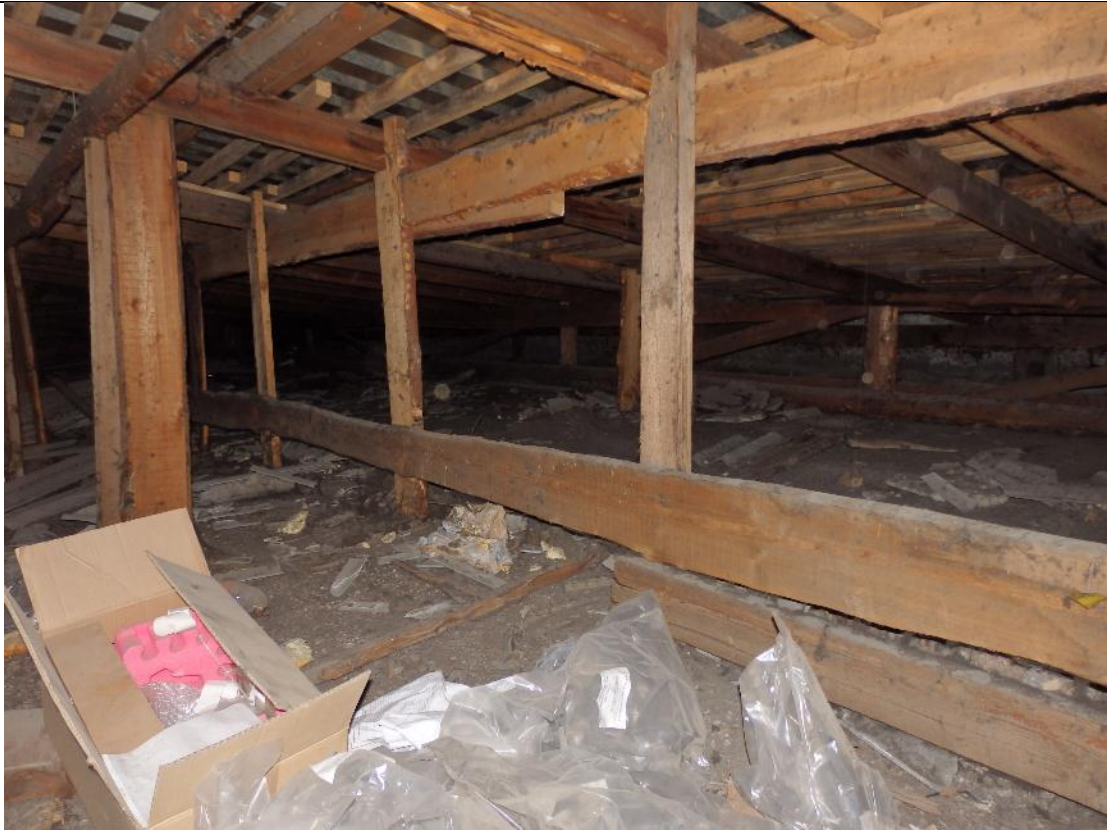
фото 21. Состояние стропильной конструкции и чердачного помещения.
