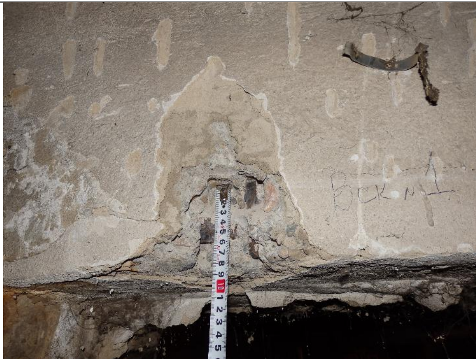
фото 63. Вскрытие №1 произведено на железобетонной балке перекрытия подвала в осях 5-6/Д.
