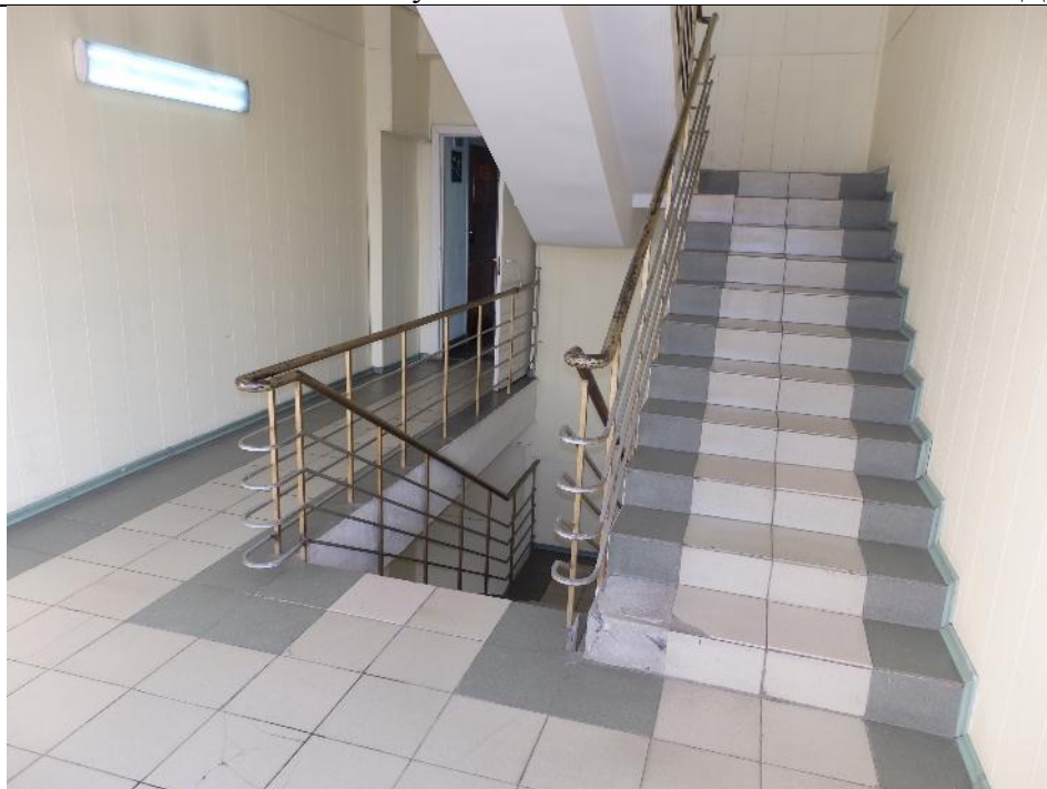
фото 34. Состояние междуэтажной лестничной клетки в осях 6-7/Д-Е.
