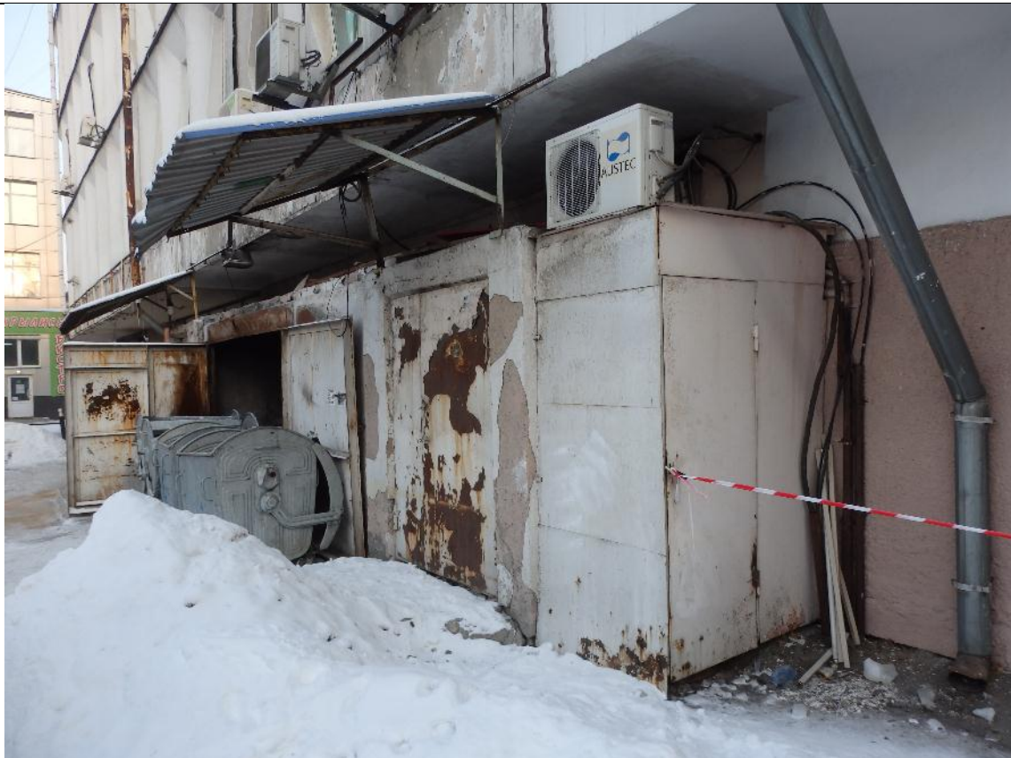
фото 9. Состояние входных групп, расположенных по фасаду в осях 6-3/Е. Отмечены участки нарушения отделочного слоя.
