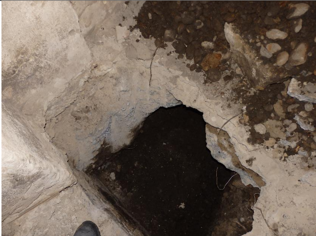
фото 65. Шурф № 1, пройденный у колонны подвала в осях 6/Д.
