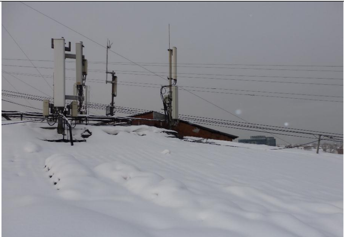
фото 16. Общий вид крыши.
